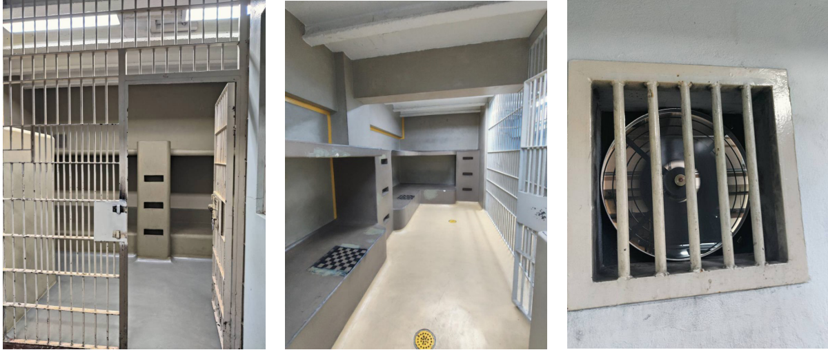
Fotos: izquierda y centro, vista interior de celdas del I Circuito Judicial de San José; derecha, abanico inyector de aire hacia el área de celdas.
