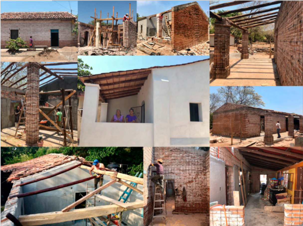
Proceso de reconstrucción y reforzamiento de la vivienda dañada.
