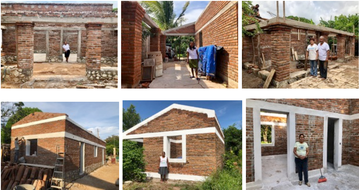
Distintos modelos de vivienda nueva reforzada
