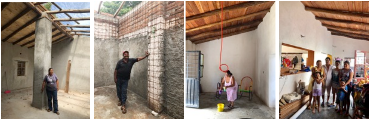
Reforzamiento de vivienda tradicional en proceso.
