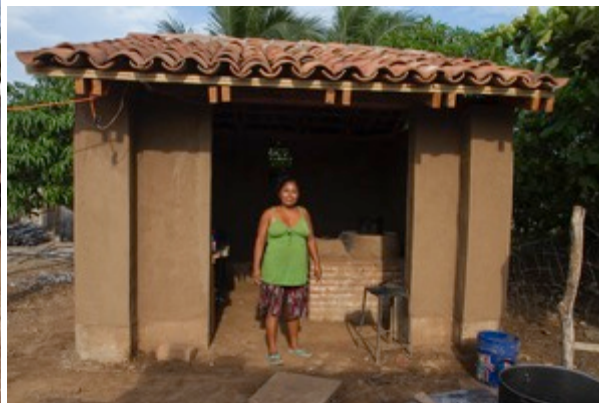
Cocina reconstruida en bajareque Cerén.
