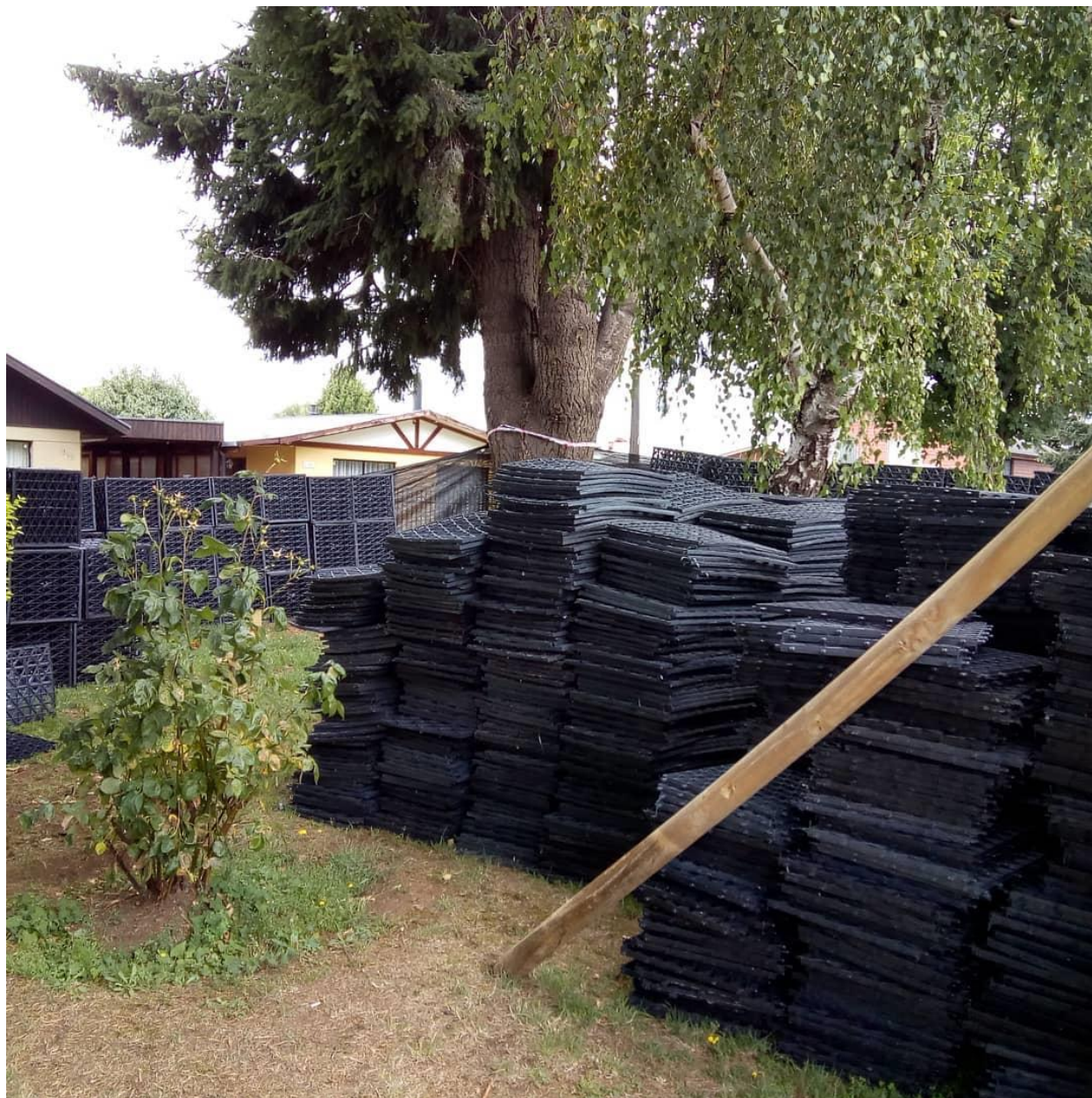
Ilustración 1: Bloques de plástico negro reciclado, almacenado sobre la plaza pública donde serán instalados bajo tierra como drenaje, en la ciudad de Temuco, año 2021. Fotografía de RADA.
