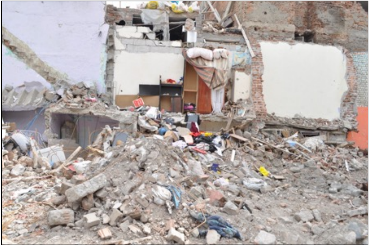
PHOTO 9- DESCTRUTION IN SUR
