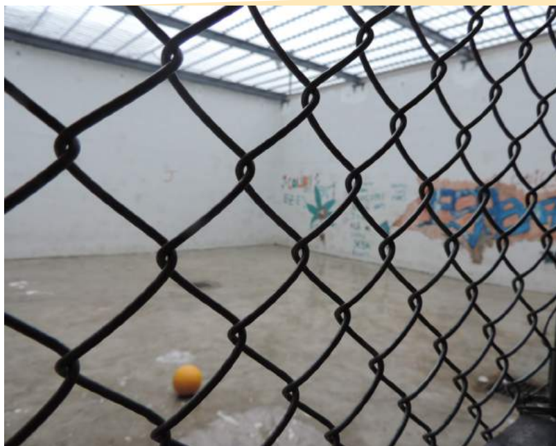
Complejo Belloni, patio. Registro fotográfico equipo MNP.
