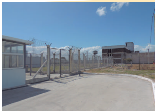
Módulo 12, Unidad 4 (ex COMCAR). Registro fotográfico equipo de MNP.
