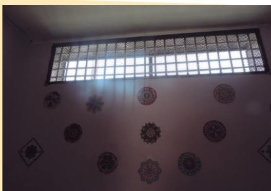
Celda CIAF. Registro fotográfico equipo MNP.
