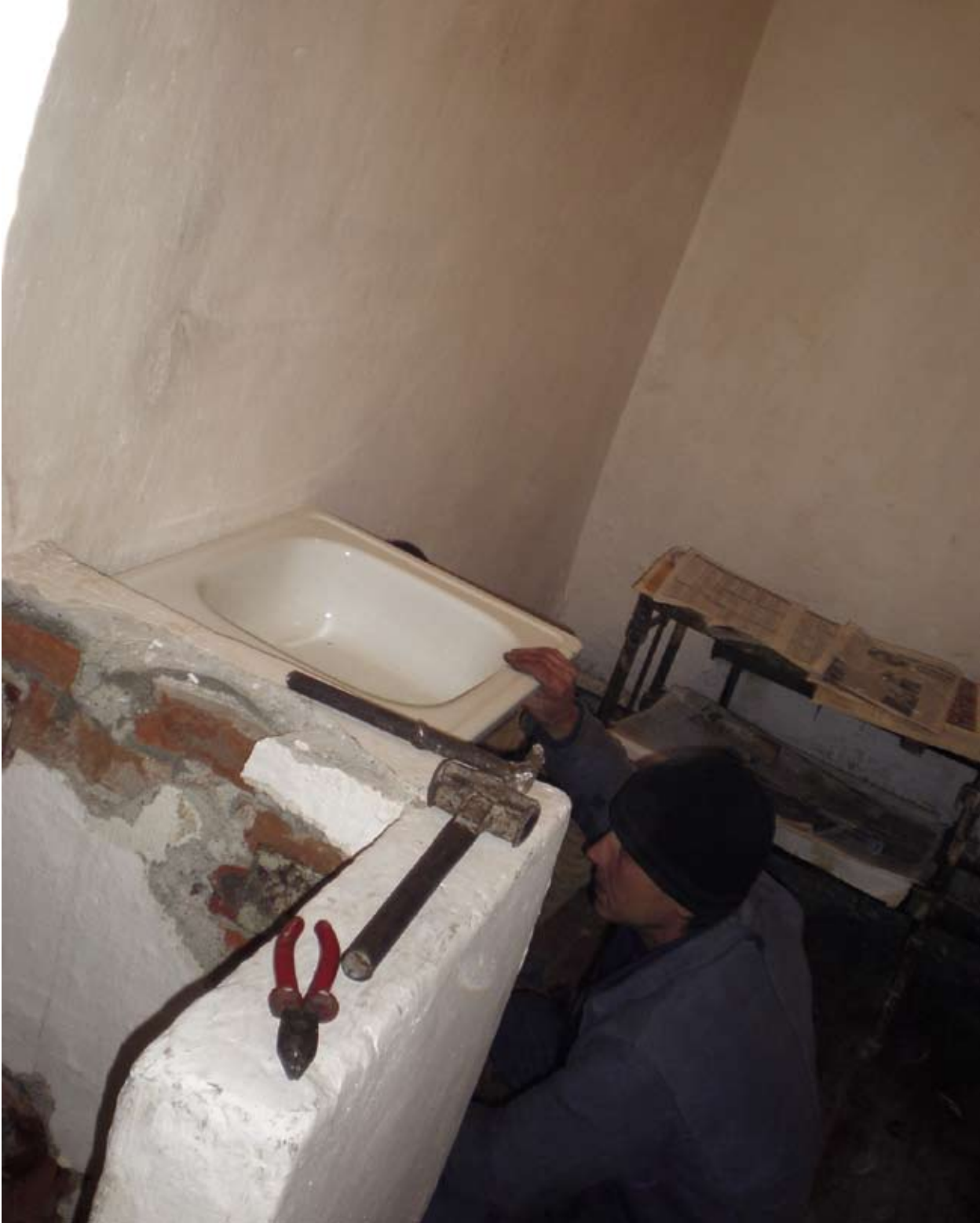
Instalarea lavoarului, Instituția penitenciară nr. 5, or. Cahul Установка умывальника, Пенитенциарное учреждение № 5, г. Кахул The installation of the wash-hand basin, the Penitentiary Institution No. 5, Cahul
