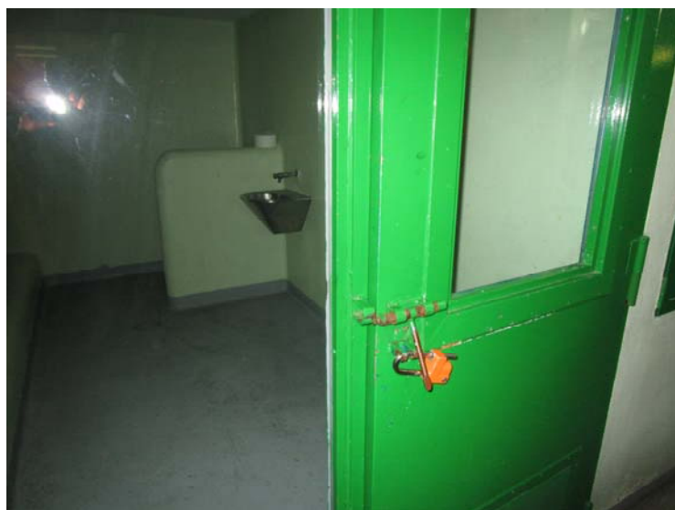
Celda colectiva con aseo interior en la Policía Foral de Pamplona (Navarra)
