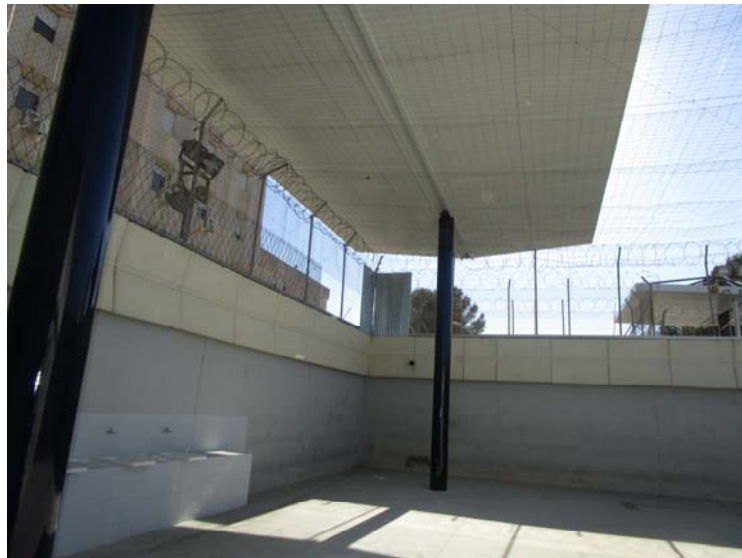
Techado parcial en el CIE de Murcia
