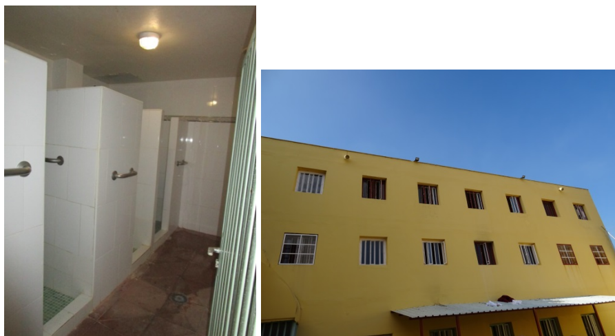
Vista interior y exterior del HPP de Sevilla
