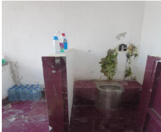
Baño de patio de CP Valencia
